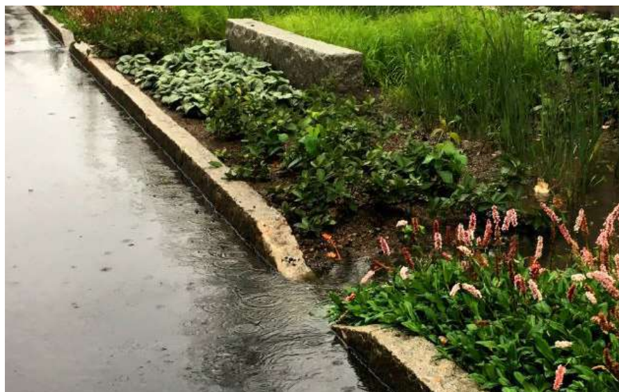
9 Vsakovací průleh s trvalekovým záhonem, zdroj: atelier Edge
